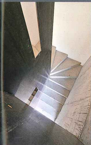
La lamiera in acciaio da 7,5 mm delle scale ha funzione strutturale
