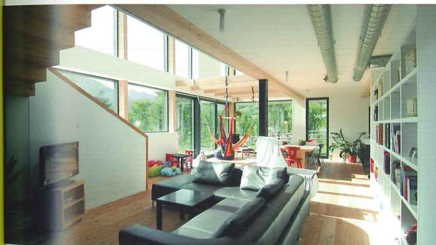
Sopra: il lungo parapetto massivo interno funge da accumulatore solare. Esso infatti, essendo posto proprio di fronte alla grande vetrata rivolta a sud, accumula calore rilasciandolo durante le ore non soleggiate.
